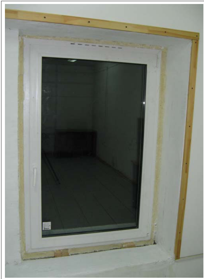
Общий вид образца, смонтированного в проеме звукомерных камер (вид со стороны камеры высокого уровня)
